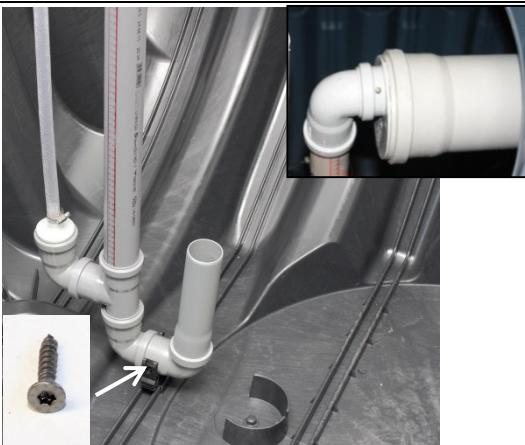
Schlammrückführung in Halteklammer stecken und mit Spax-Schraube zusätzlich sichern. Oben im Tank die Schlammrückführung in das Rohr für die Schlammrückführung stecken.
