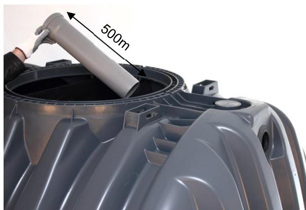
Ablauftrohr von innen durch die Auslaufbohrung schieben.
